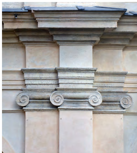
4. Roma, S. Bibiana. Pilastratura in facciata a tre paraste ioniche affiancate. In evidenza le edulcorazioni pittoriche simulanti ombreggiature fittizie (foto Ticconi, 2015)
